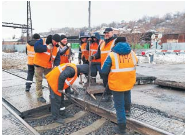
Идёт ремонт переезда на 1173 км станции Новочеркасск
