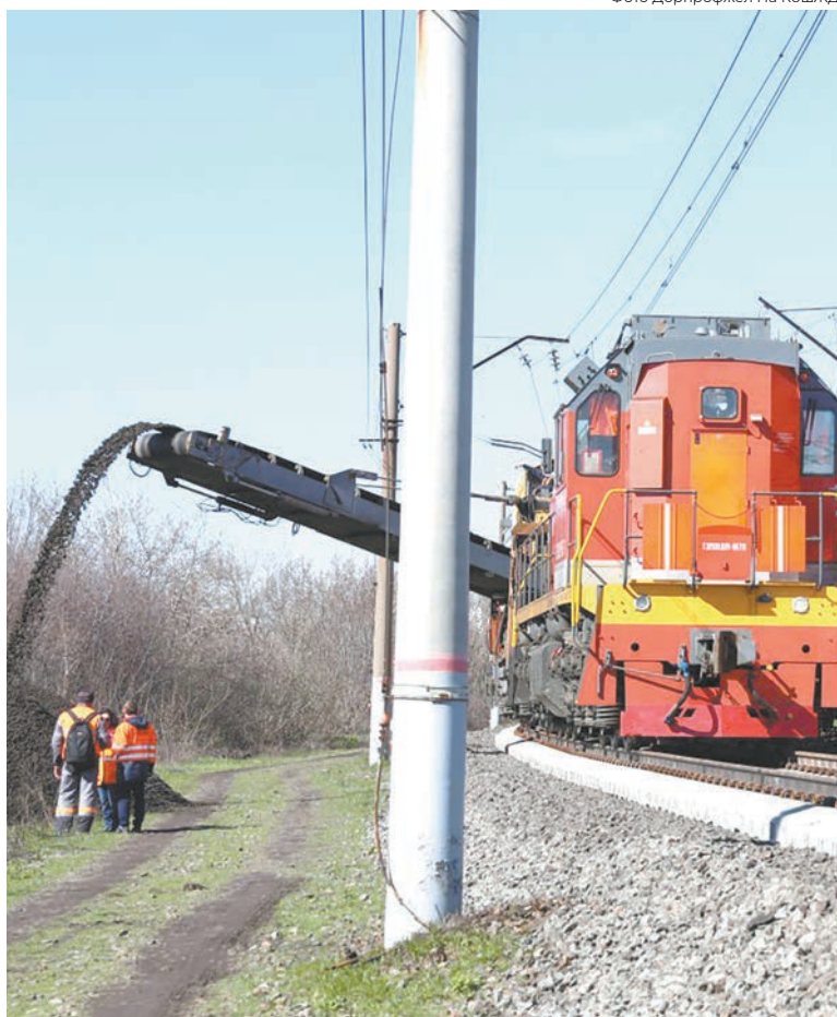
Фото Дорпрофжел на КбшЖД
